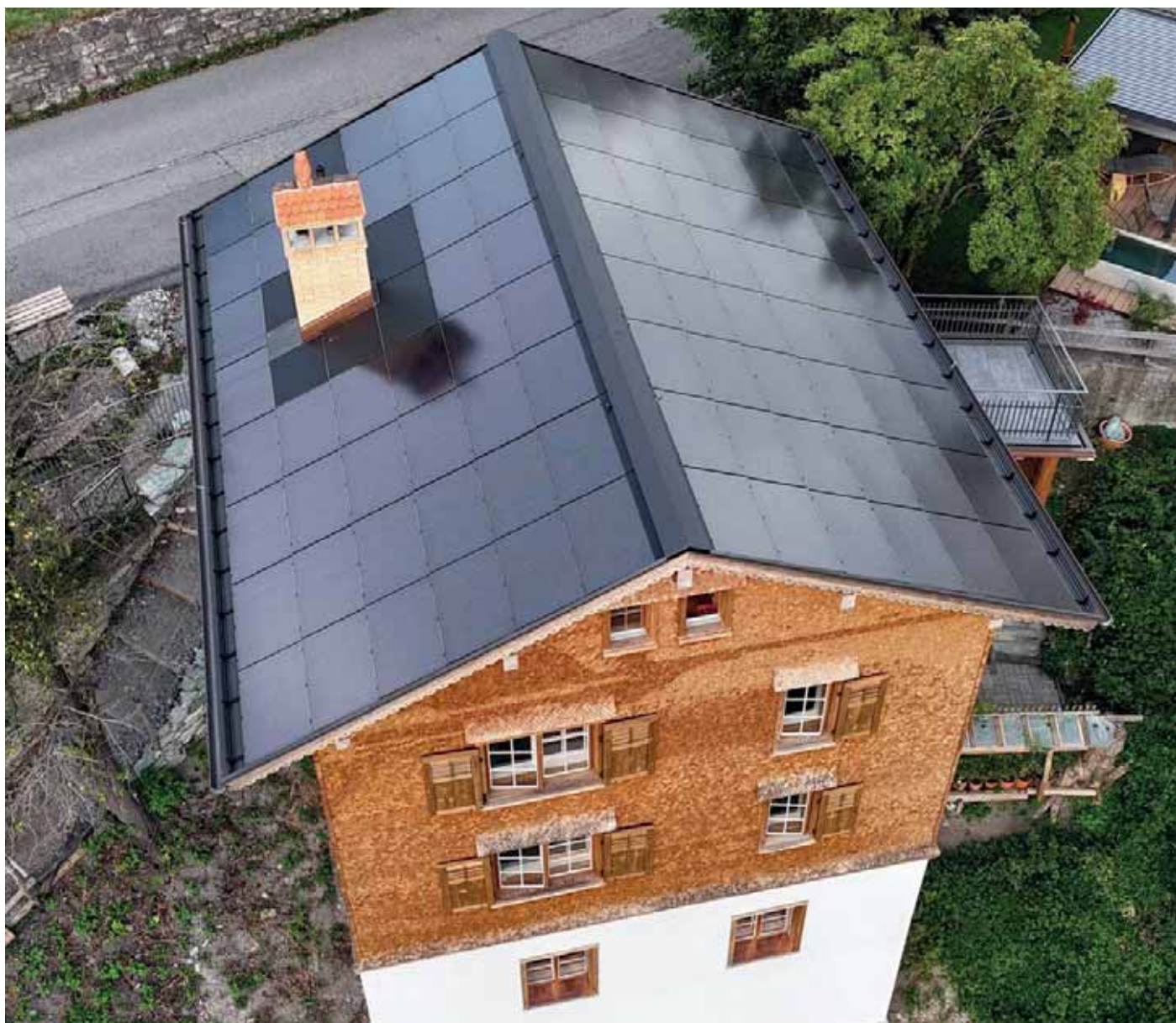
Abb. 1: Die neu installierte PV-Dachanlage mit einer Leistung von 17,55 kWp produziert jährlich rund 16'700 kWh CO 2 -freien Solarstrom.
