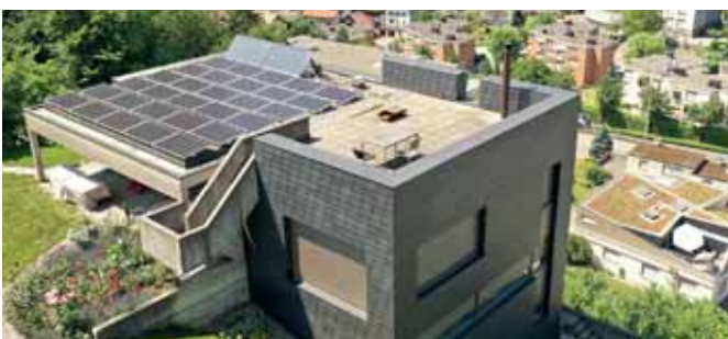
114% PlusEnergie-EFH Sanierung, Wollerau (2019)
