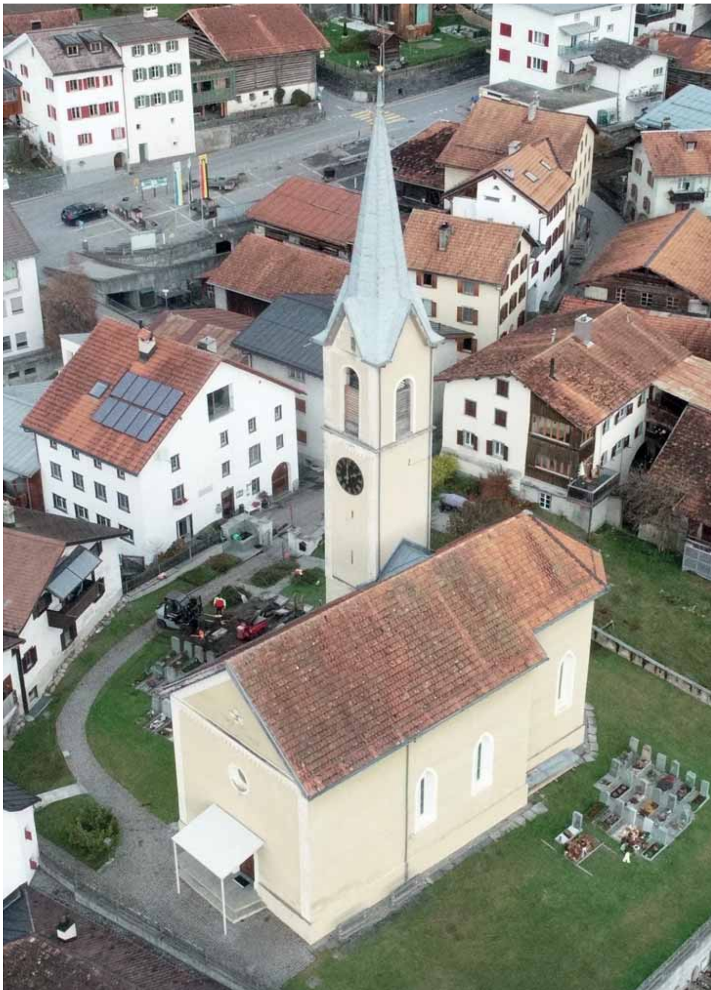
Abb. 4: Die reformierte Kirche Trin vor der Sanierung und vor der perfekt ganzflächig installierten Solarstromanlage auf dem Dach.
