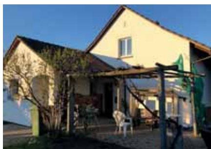
Abb. 1: Die alte Bausubstanz vor der Erweiterung und Sanierung.
