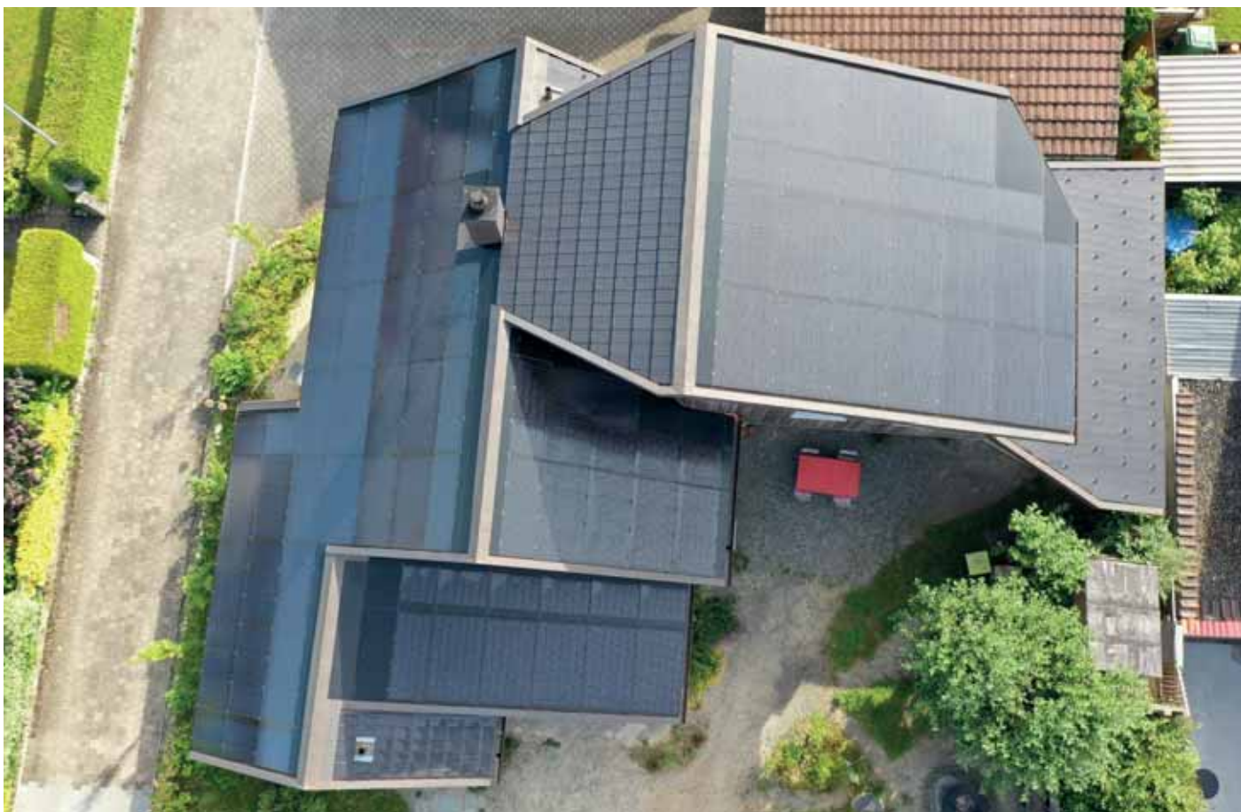
Abb. 4: Die PV-Dachmodule sind sorgfältig in das Dach integriert. Dabei wurde die komplizierte Dachfläche vorbildlich ganzflächig genutzt.
