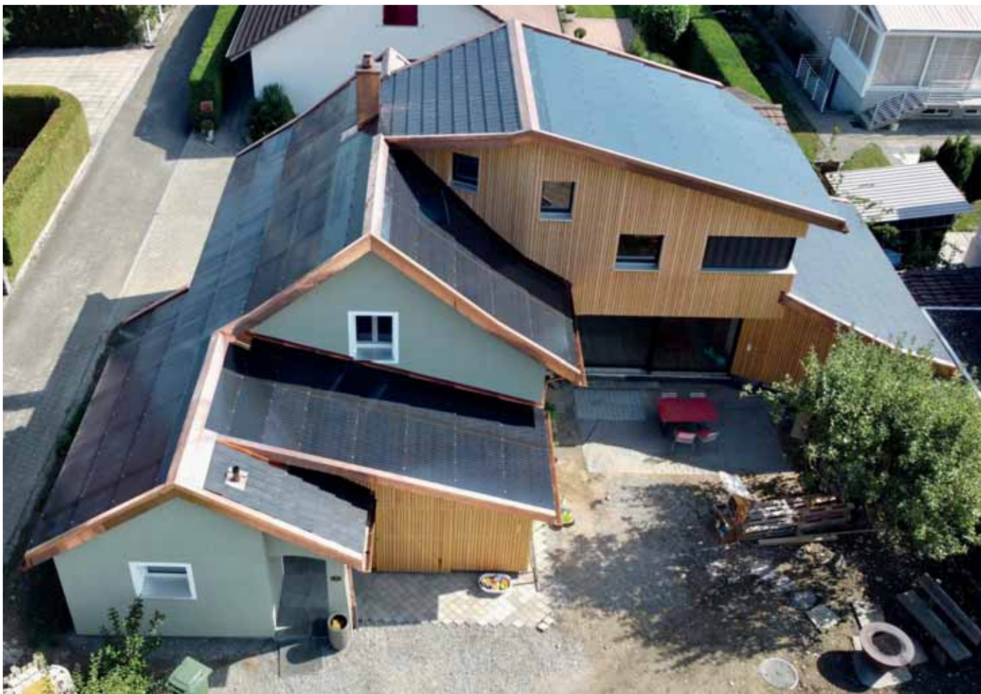
Abb. 3: Am Breitlohweg wurde das Gebäude nicht nur erweitert und energetisch saniert, sondern auch eine ganzflächig nahezu perfekt integrierte PV-Dachanlage installiert.
