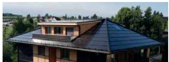
Abb. 1c: Min. P-gedämmtes PV-Dach mit ganzflächig vorbildlich integrierter Solaranlage, um mehr CO 2 -freien Winterstrom zu generieren.
