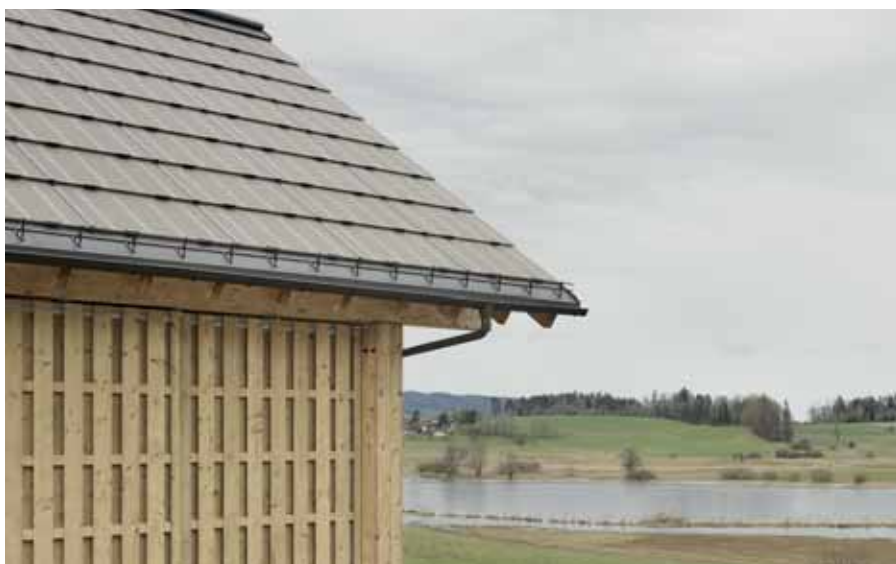
Abb. 2, 3: Durch die Verwendung lichtdurchlässiger PV-Paneele gelangt Sonnenlicht auch in die Scheune selbst, wodurch der Bedarf an künstlicher Beleuchtung erheblich reduziert wird.
