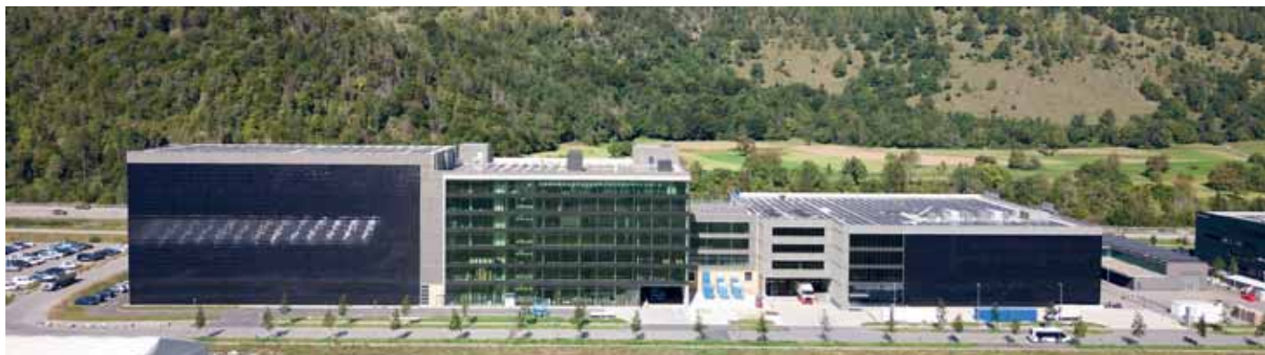
Abb. 2: Die Frontansicht besticht architektonisch und durch ihre nachhaltige Energieversorgung mit 125 kWh/m 2 a. Dank 833'800 kWh CO 2 -freiem Solarstrom können jährlich 556 E-Autos emissionsfrei je 10'000 km fahren.
