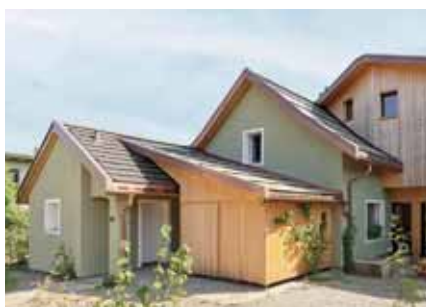
Abb. 2: Der erste Schritt der Sanierung: die Erweiterung des Gebäudes.
