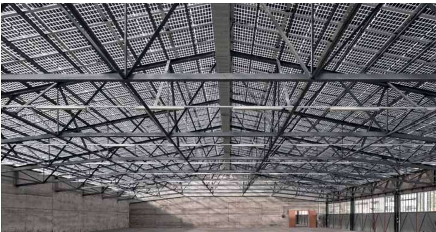
Fig. 3 : l'utilisation de modules verre-verre transparents permet de garantir qu'une quantité suffisante de lumière solaire résiduelle pénètre également dans la halle elle-même.
