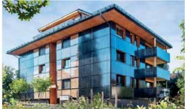
Abb. 1b: Die 315% PEB-Sanierung nutzt möglichst ganzflächig die perfekt integrierten PV-Dach- und Fassadenflächen. Sie generiert mit 78'000 kWh einen Solarstromüberschuss von 53'000 kWh/a. Damit deckt sie 315% des Gesamtenergieverbrauchs von 25'000 kWh/a für 7 Wohnungen (vgl. Tabelle).
